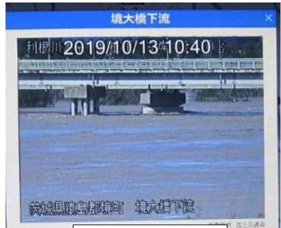
越水危険水位状況
